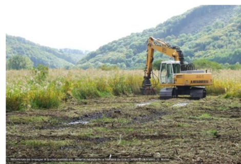
Fig 27 : Travaux de réouverture dans la réserve naturelle en 2010.
